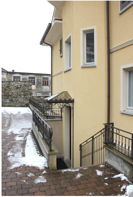
Eingang, Bad und Küche mit Wohnraum ● entrata, bagno, cucina e soggiorno
