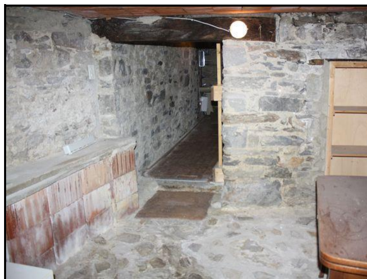
Vorraum zum Massenlager
