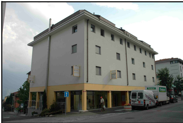
Facciata nord con entrata / Nordfassade mit Eingang
